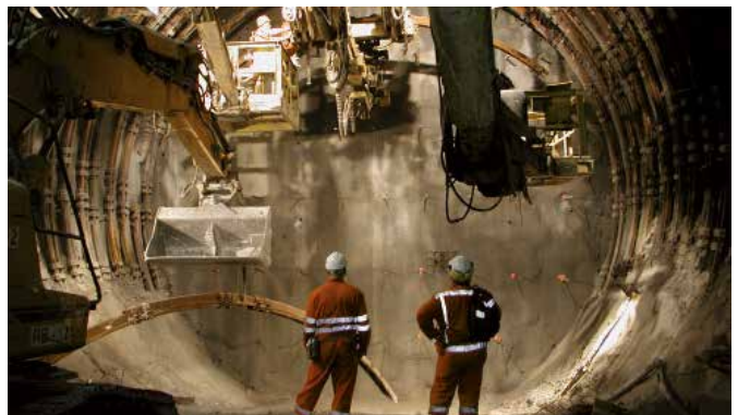
Gotthard Basistunnel, Vortrieb im Tavetscher Zwischenmassiv
